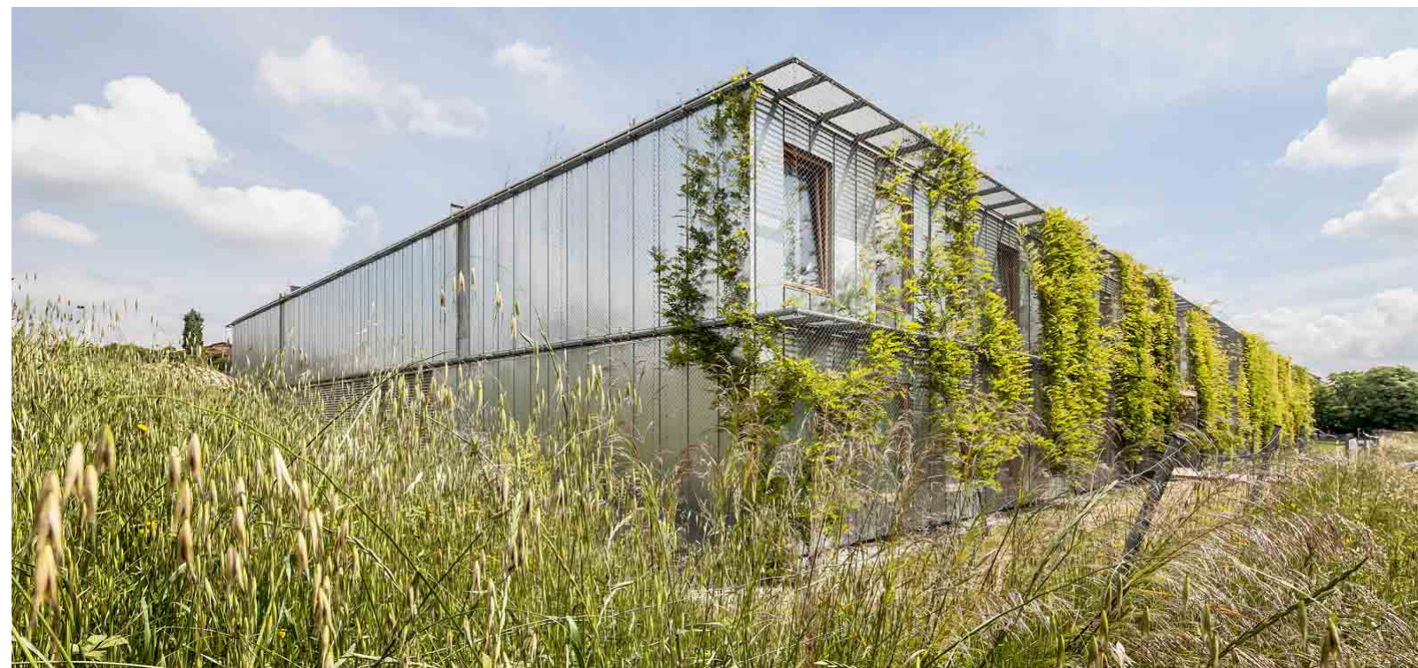
växter klättrar i fasadnätet och blir den del av byggnadens uttryck
