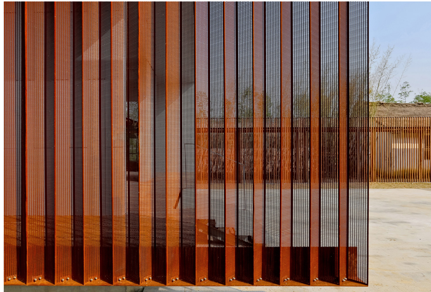
tack vara fasadens veckning uppstår en dynamisk effekt när metallnätet skiftar i transparens beroende på vilken betraktningssvinkel
