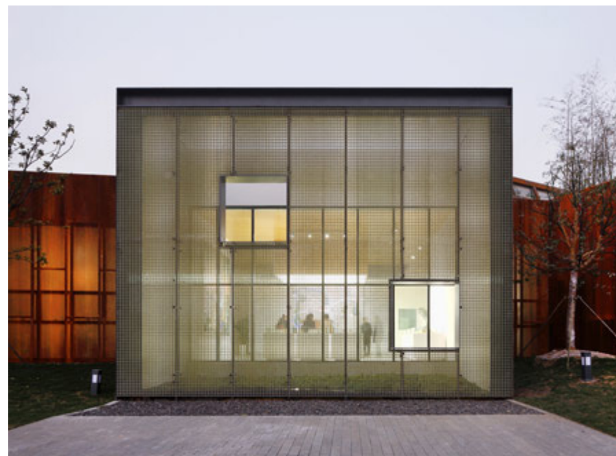
den enhetliga fasaden av metallnät får tydligt utskurna hål
